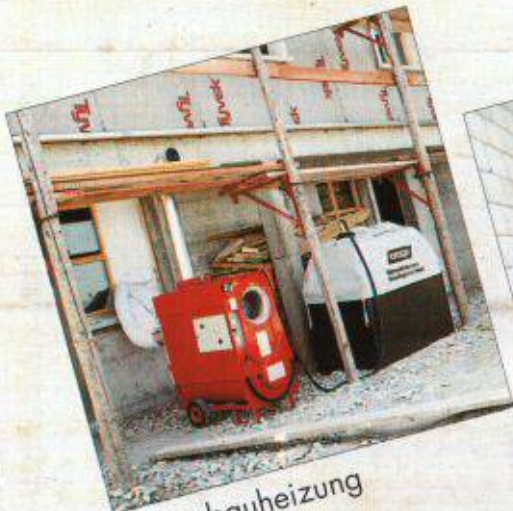
Bauaustrocknung
