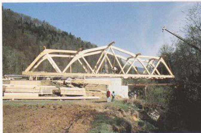
Bild 8. Das Haupttragwerk wurde neben dem Fluss auf Stahlprofilen vormontiert und auf Gleitlagern eingeschoben. Der vordere Teil der Brücke ist an einem Autokran aufgehängt
