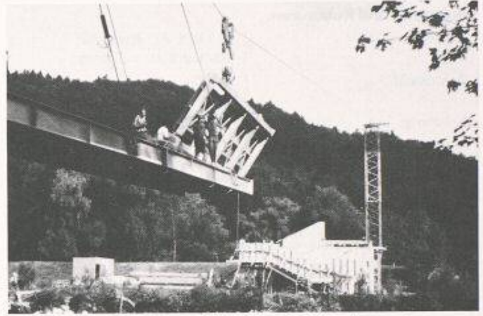
Bild 6. Montage im Freivorbau: Ein Brückenelement hängt am Kabelkran kurz vor dem Absenken und Ansetzen
