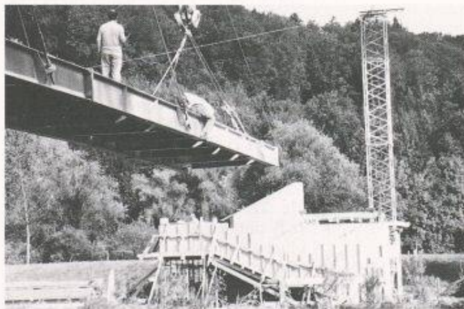
Bild 7. Das Brückenelement ist angesetzt und wird verschraubt. Die Seilabspannung ist noch nicht eingezogen
