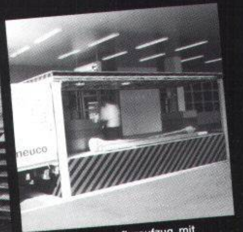
z.B. Scheren-Unterfluraufzug, mit Baldachin-Schachtabdeckung
