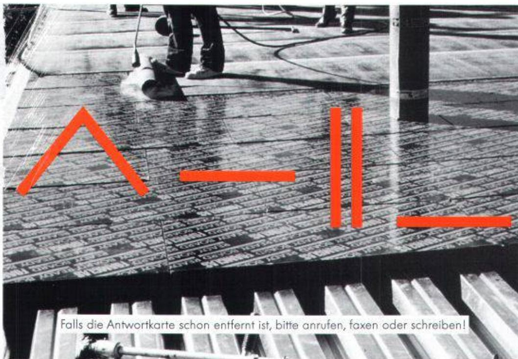
FOAMGLAS®-READY BOARD, eine Weiterentwicklung von Pittsburgh Corning für die Dämmung von flachgeneigten und steilen Dächern mit Metalleindeckung (im Bild die Verlegung einer Bitumenschweissbahn als Sekundärabdichtung unterhalb der nachfolgenden Blecheindeckung).
