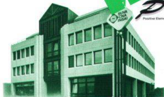
Geschäftshaus Adlikerkreuz, Regensburg, Rötlich eingefärbte, sandgestrahlte Sandwich-Fassaden.
