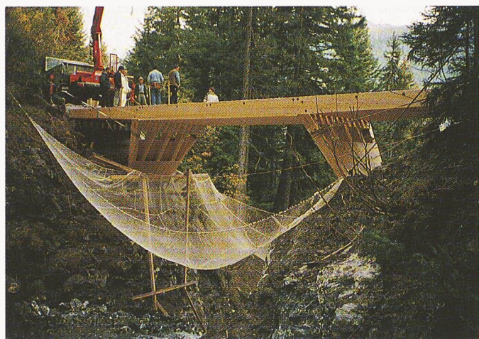
Die Drostobelbrücke im Bau
