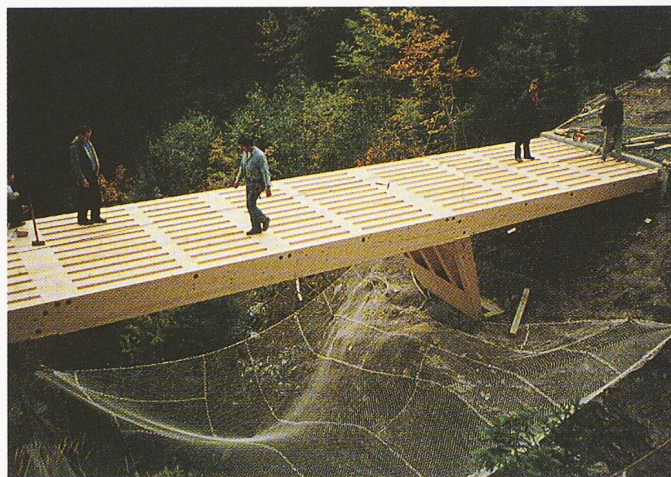
Die Fahrbahn aus Furnierschichtholz
