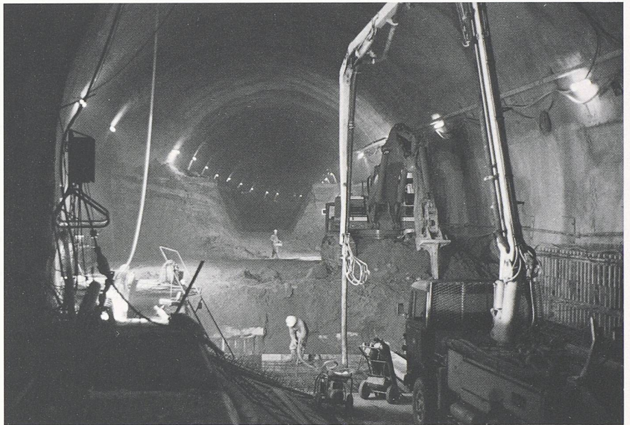
Bild 7. Strossenabbau und Sohlgewölbe in der Molasse
