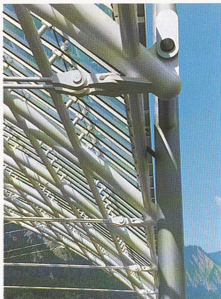
Bild 13. Anschlussdetail Zugbänder und Aufständigung Dachhaut
