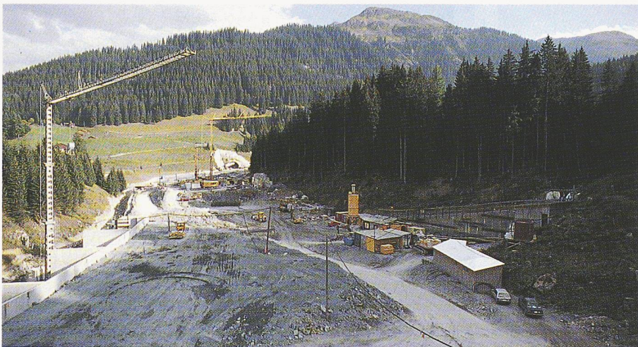
Bild 10. Bau- und Installationsstellen in Sglaia (Engadin)
