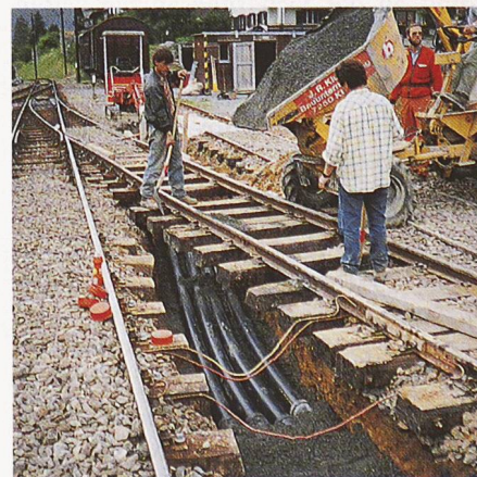
Bild 7. Auch einfachere Bauarbeiten sind im Bahnbetrieb behindert
