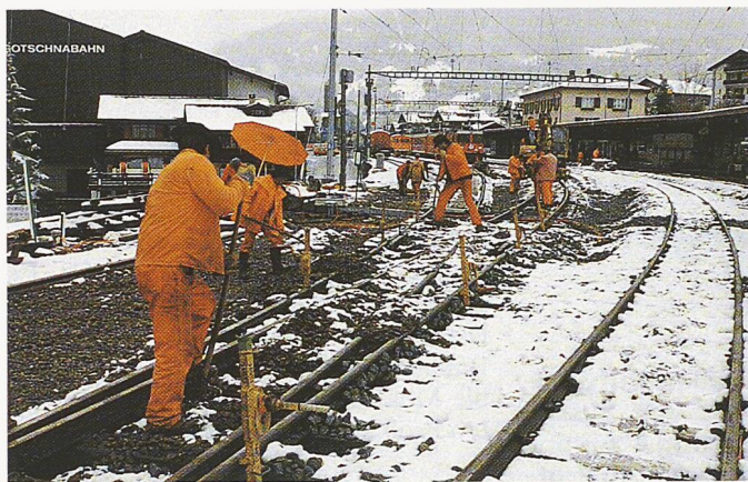
Bild 9. Gleisumbau im Oktober 1992 bei misslichen Wetterbedingungen
