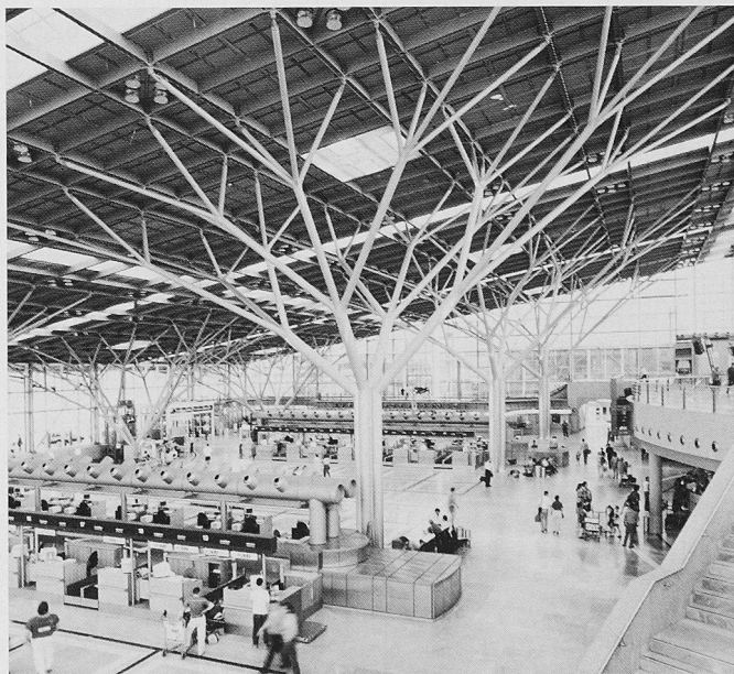
Bild 2. Stuttgart: filigrane Baumstützen aus Rundrohr im Flughafenterminal
