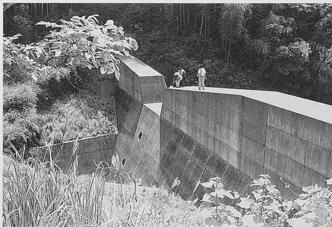
Bild 8. SABO-Einheitsdamm bei Kōchi (Foto: M. Zimmermann)
