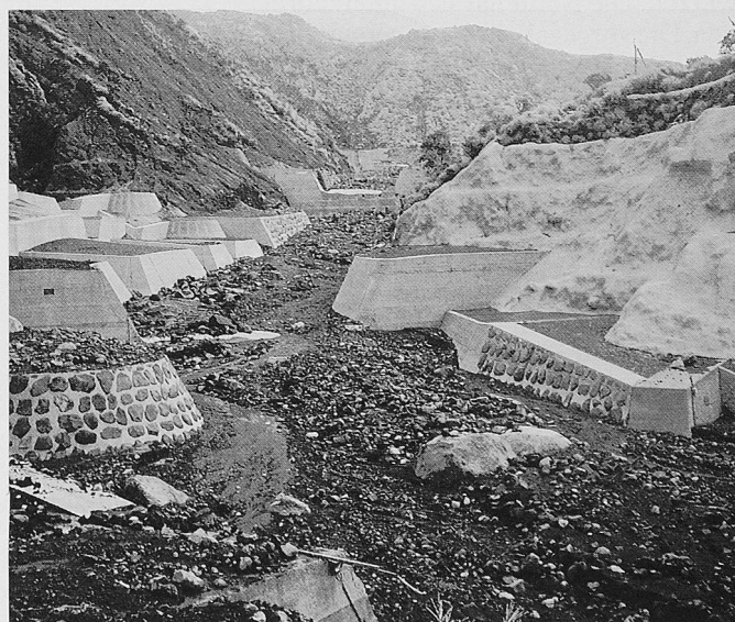
Bild 6. Klassischer Sperrenverbau am Mount Sakurajima soll eine gezielte Führung von Murgängen ermöglichen. (Foto: M. Jäggi)
