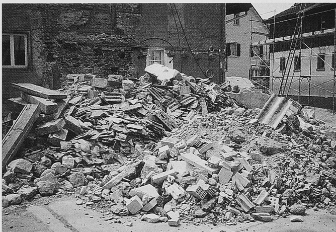
Das Sortieren und die Wiederverwendung von Bauschutt, der bisher verbrannt, deponiert oder sonstwie entsorgt wurde, hilft Ressourcen und Kosten sparen.
