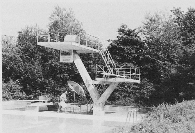
Bild 2. Sprungturm mit Tilger
