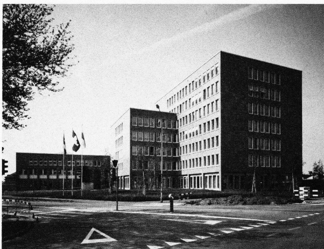
Bild 3. Gerichtsgebäude sowie Ost- und Nordflügel des Verwaltungsgebäudes
