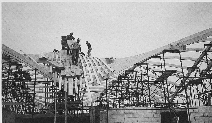
Schalungsaufbau für die Villa Darier in Genf: Bei der Herstellung freier Schalenformen ist Präzision von grösster Wichtigkeit. Die Binder und Holzschalungen sind Meisterwerke der Zimmermannskunst
