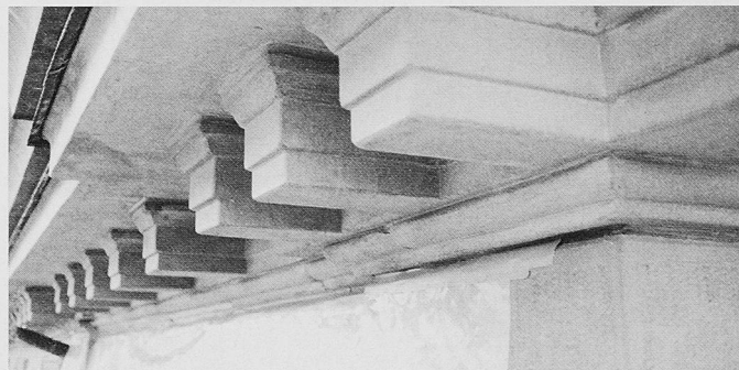
Bild 12. Überarbeiten von abblätternden Dachgesimsen
