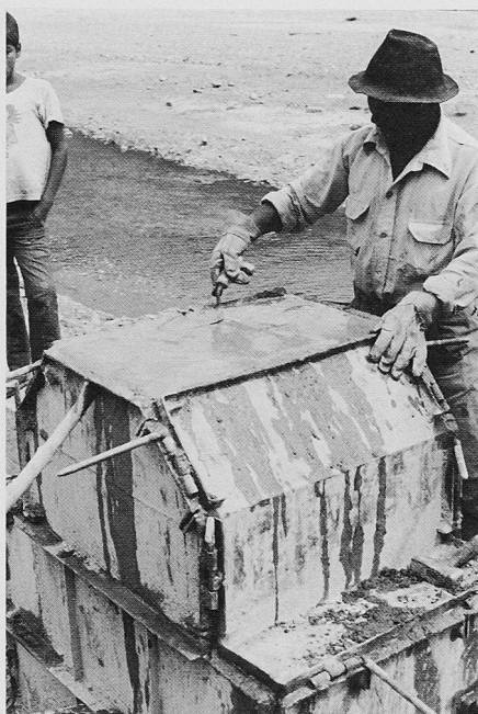
Bild 12. Ein Block ist fertig gegossen (Bild: E. Decormis, Sucre)
