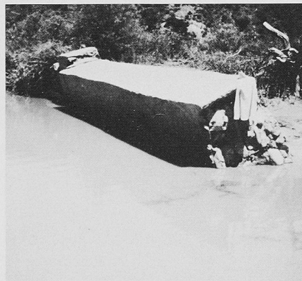
Bild 5. Mehrere Meter unterhalb des Flussgrundes fundierte Mauern werden innert weniger Jahre unterspült
