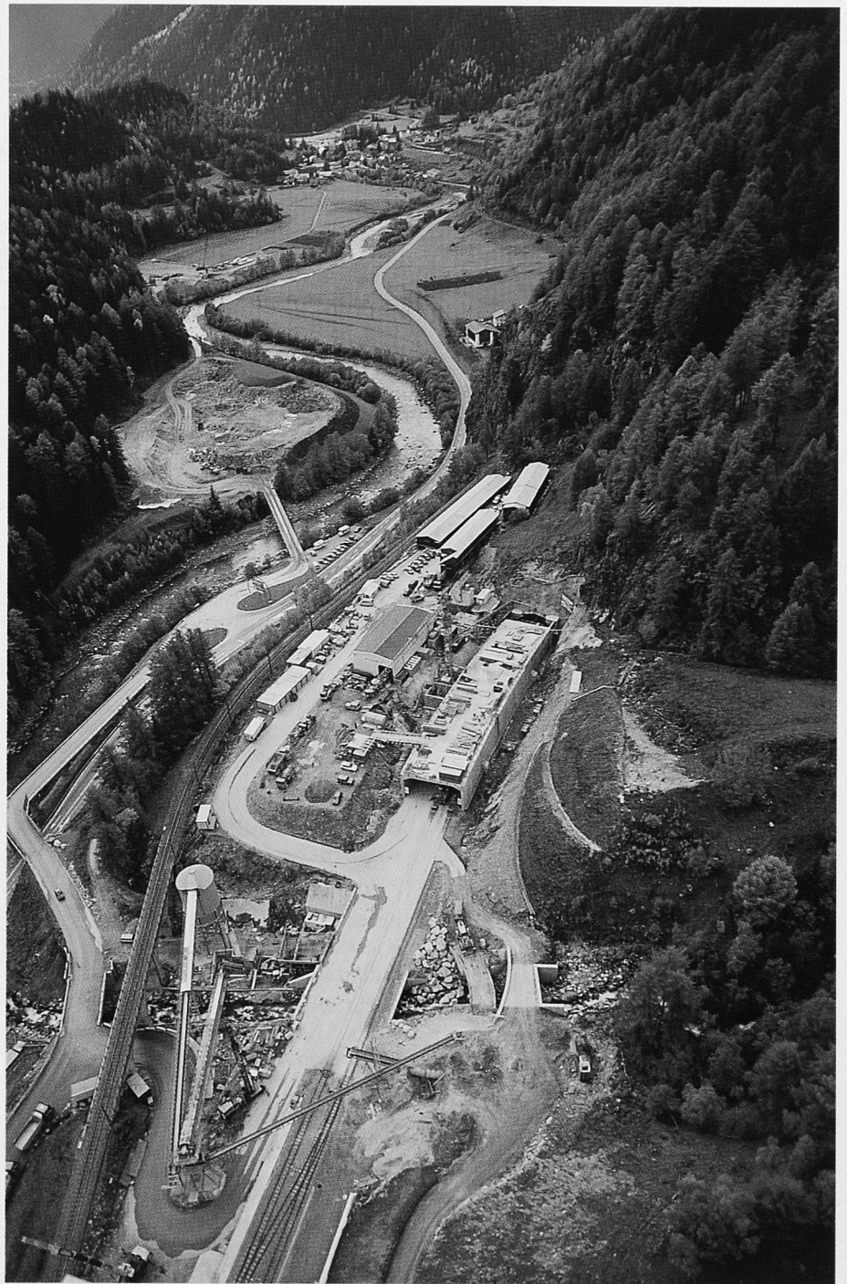
Bild 1. Übersicht über das Installationsgelände und den Portalbereich
