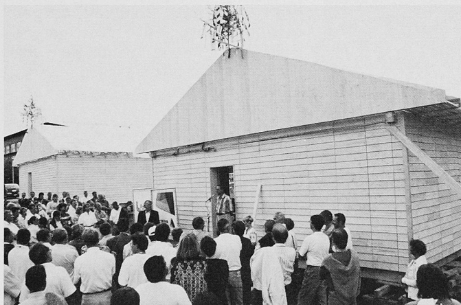
Holzbau, einmal durch Laienhände. Am Abend ist das Ziel erreicht: Die beiden Schulhäuser für Nepal stehen
