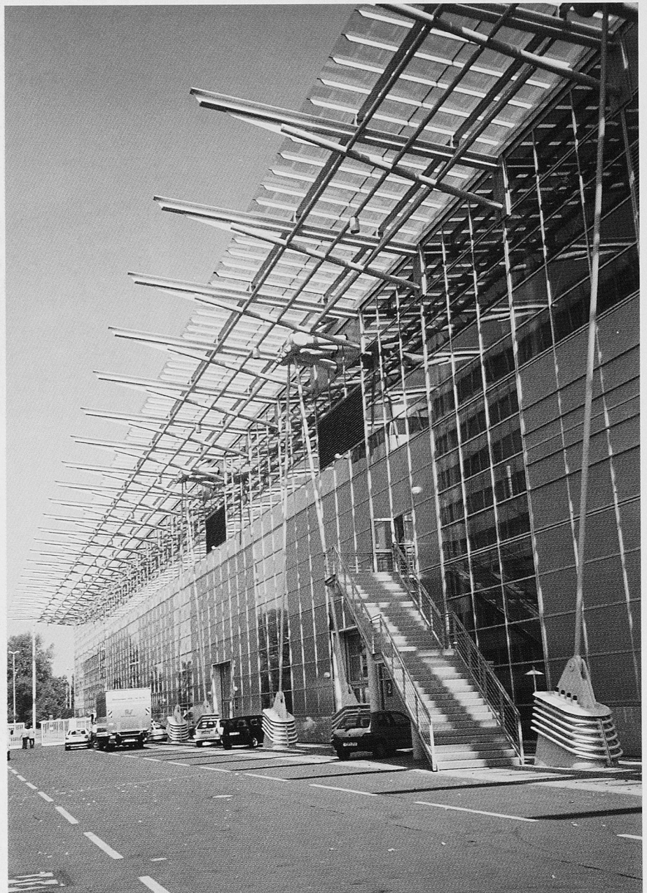
Halle 2. Südwestansicht des dreigeschossigen verlängerten Seitentraktes
