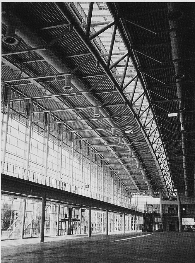
Das Innere der Haupthalle mit Galerie. Oberlichtbänder über den Dreigurtbindern
