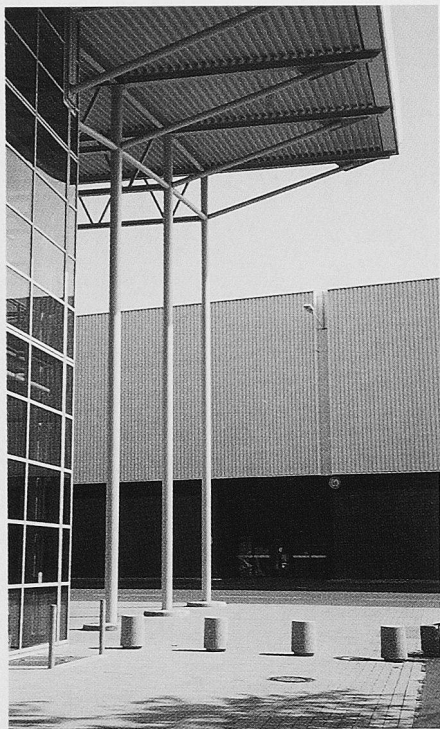
Stützen an der Eckauskragung
