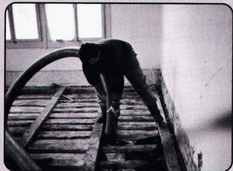
Absaugen von Zwischenböden bei Renovatio- nen, Umbauten und Sanierungen.
