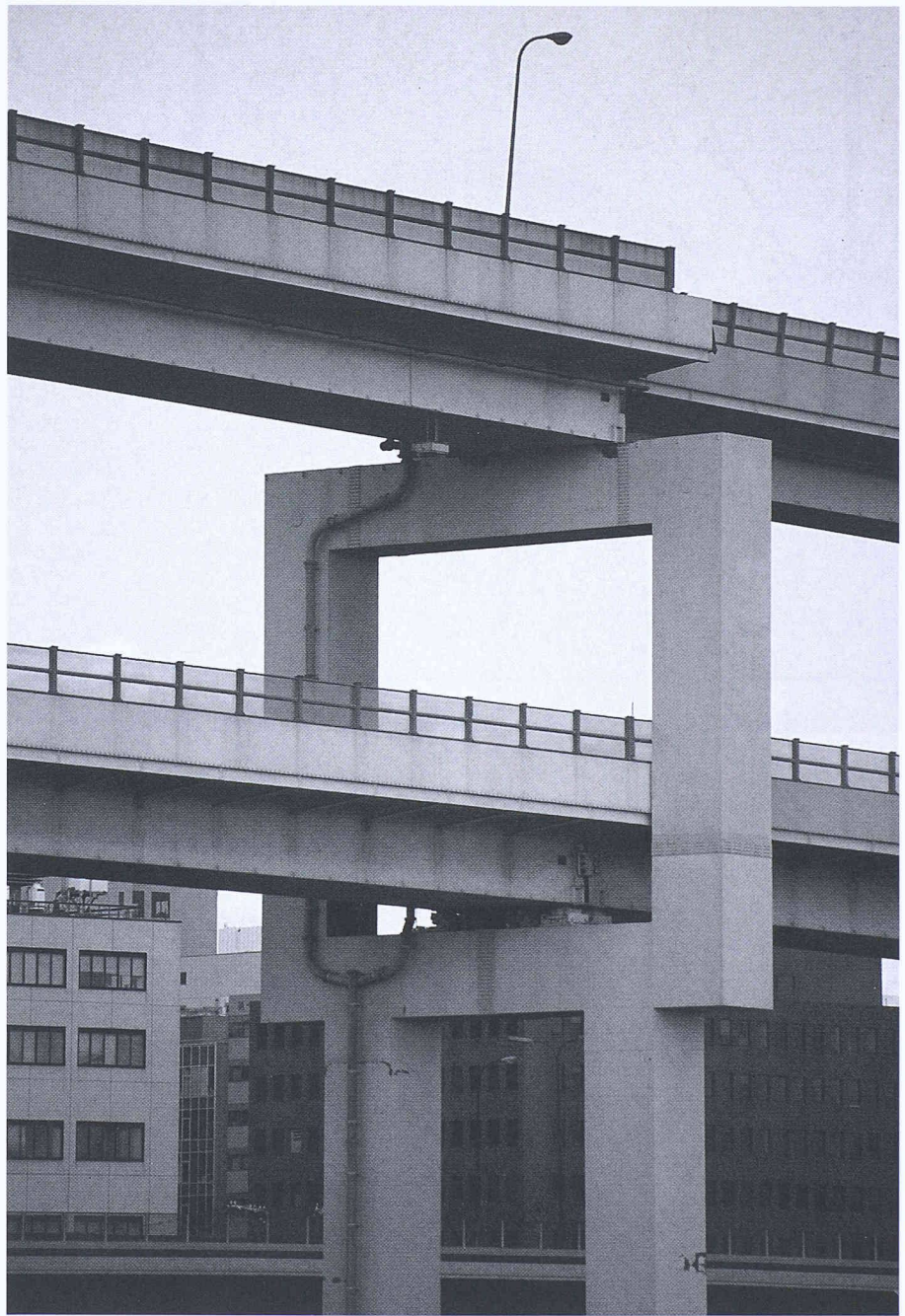
Bild 12. Beinahe-Absturz des oberen Brückenträgers
