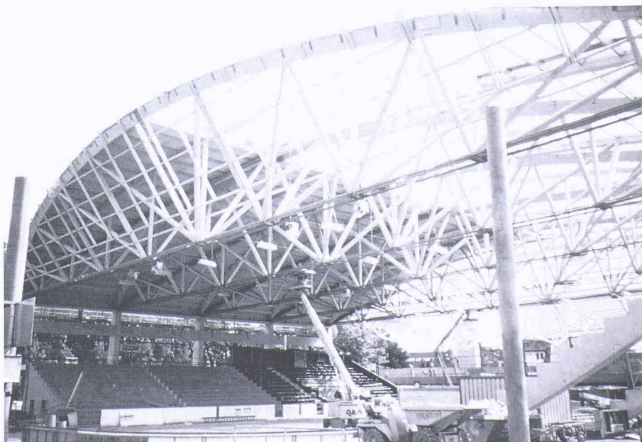
Die Dachkonstruktion aus fünf mächtigen Holzbindern ist teilweise bereits von der Dachhaut bedeckt (Bild: Isover, Lausanne)
