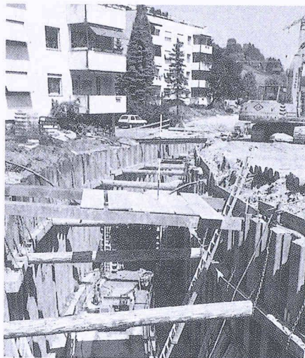
Bild 5. Ortbetonkanal, Aushubarbeiten Baugrube mit Spundwänden
