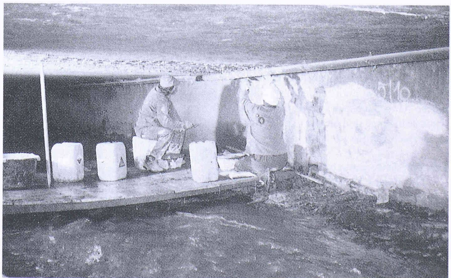
Bild 7. Missliche Arbeitsbedingungen: ständiger Schmutzwassergeruch, knappe Arbeitsverhältnisse bei Höhen von 1,40 bis 1,80 m
