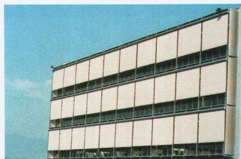
Gebäude Firmenich, Genf: Aus der Glas-Fassade wird eine «Stoff-Fassade» mit zentraler Steuerung.
