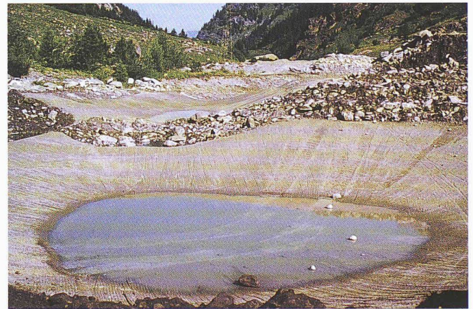
Roh gestaltete Weiherlandschaft bei Bonatchiesse. Die Sohlenabdeckung aus Kiesmaterial ist teilweise bereits eingebaut
