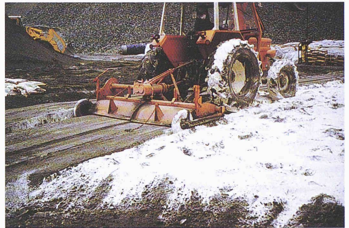
Aufbereitung der Abdichtungsmasse: Mischen mit der Bodenfräse
