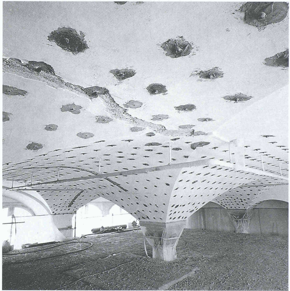
Gewölbedecke mit eingesetzten Bohrpäckern, Injektionsraster
