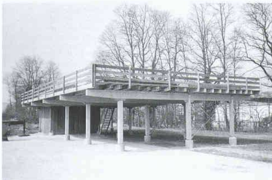
Ansicht der Versuchsanlage
