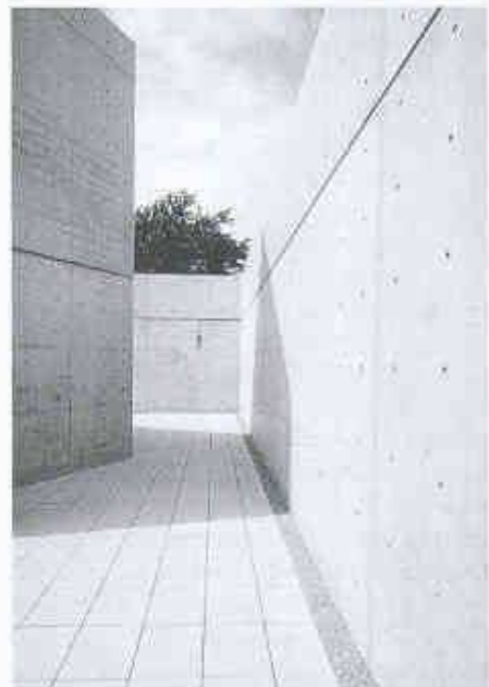
11 Ausbildungszentrum in Weil am Rhein, Architekt Tadao Ando, 1993
