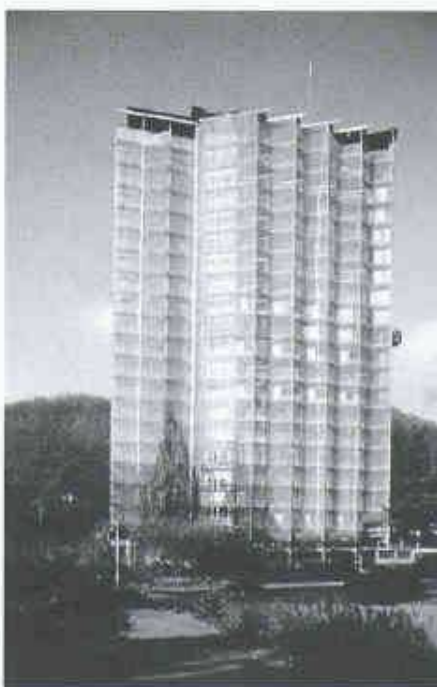
Kantonsspital Olten, Fassadensanierung Personalhaus
