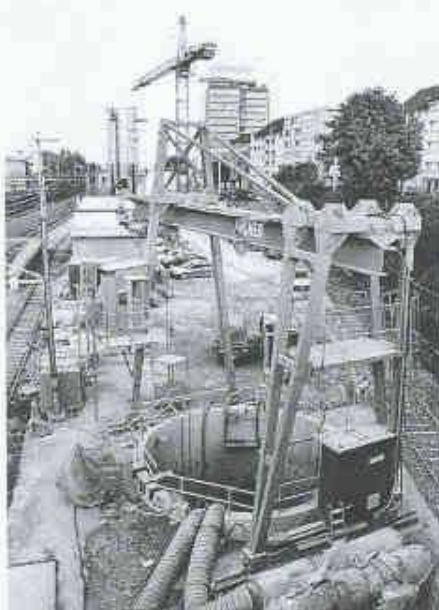
Einrichtung des Installationsplatzes am Bahnhof Oerlikon. Im Vordergrund der Vertikalschacht (Bild: Comet)
