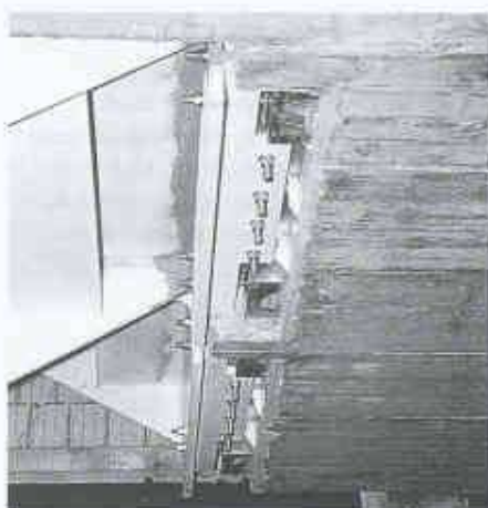
4 Aufnahme der vertikalen und horizontalen Kräfte durch zwei in den Achsen zueinander verdreht angeordnete Zug-Druck-Elemente. Oben: am Treppenflur, unten: am Mittelpodest
