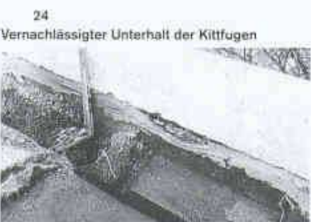
Keine Haftung verschiedener Kittarten
