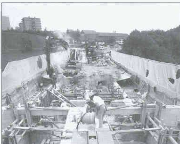
Sanierung und Verbreiterung der Pérolles-Brücke, Freiburg
