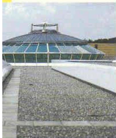
Umbau Einkaufszentrum Glatt. Mit Sarnafil T.
