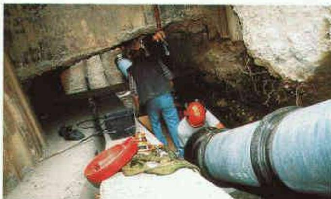
Die Wasserversorgung Zürich stellt hohe Anforderungen an ihr Rohrmaterial, soll es doch über mehrere Generationen problemlosen Wassertransport gewährleisten. Sie verwendete als Rohrmaterial in diesen Projekten das duktile Steckmuffengussrohr mit Faserzementmörtel-Umhüllung (FZM) von Buderus.
