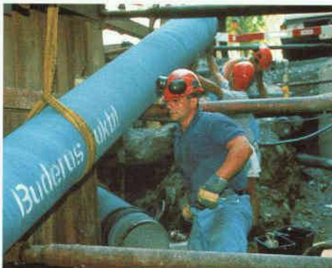
Deutlich erkennbar sind die millionenfach bewährte Tyton-Sit-Schubsicherung wie auch der blaue FZM-Panzer und die Gummimanschette am Spitzende, die den hermetischen Schutz des Muffen-/Spitzendebereichs gewährleistet.
