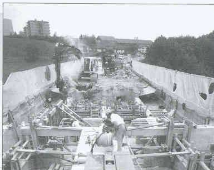
Sanierung und Verbreiterung der Pérolles-Brücke, Freiburg
