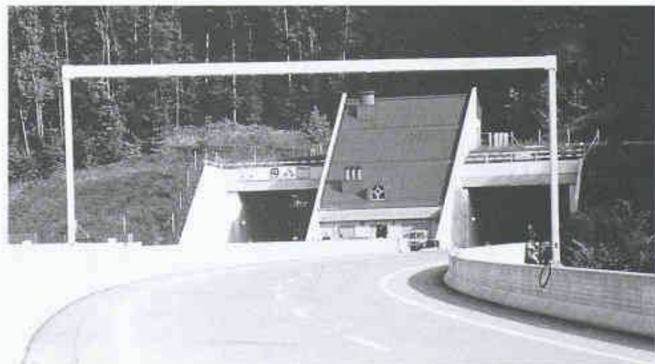
Betriebszentrale Nord des Habsburgtunnels zwischen den beiden Tunnelröhren. Das Dach übernimmt die Hangneigung
