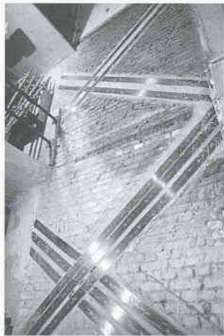
5 Anordnung der CFK-Lamellen auf der Mauerwerktragwand
