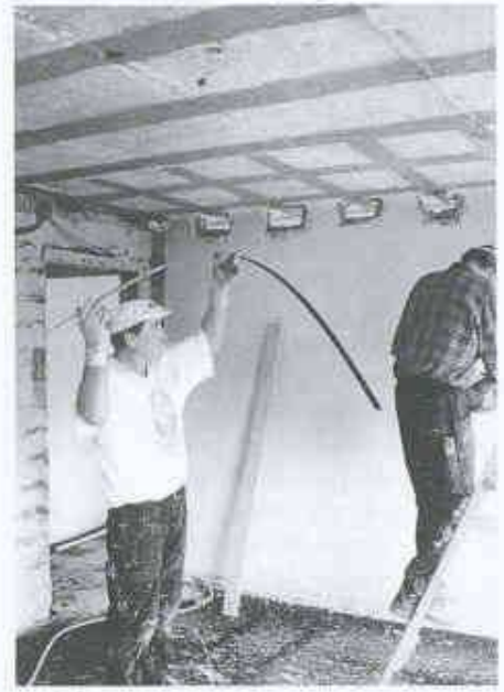
8 Montage von CFK-Lamellen
