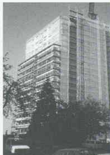
Das voll eingerüstete und gesicherte Mehrfamilienhaus
