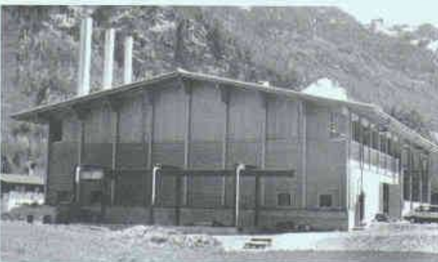
Das Heizkraftwerk Meiringen macht aus Holz Wärme und Strom
