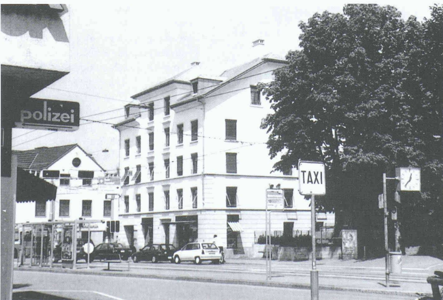
Orsini-Haus, Zürich-Höngg: Bei diesem Objekt, das noch 1987 hätte abgebrochen werden sollen, wurde mit bescheidenen Mitteln gekonnt in die bestehende Bausubstanz investiert. Es entstanden Kleinläden und Studentenwohnungen, bei denen zudem der Energieverbrauch drastisch gesenkt werden konnte
