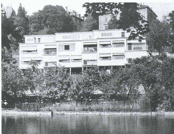
3 Rotachhäuser, Zürich. Architekt Max Ernst Haefeli, 1928–29 (rechts)
