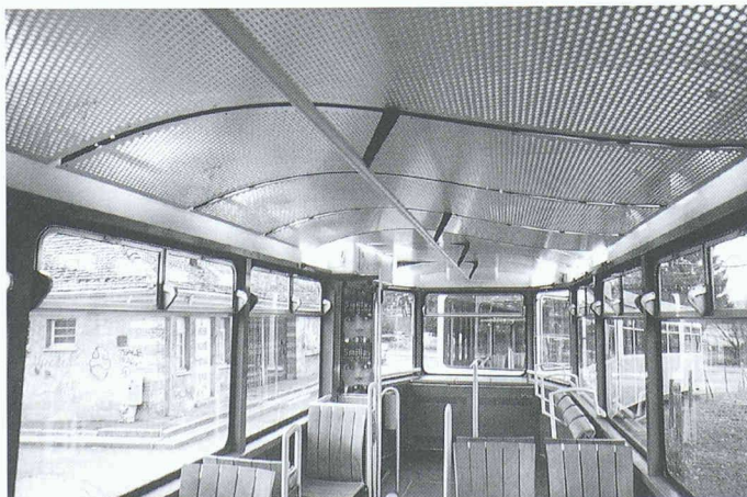
Bei der Beleuchtung im Regenbogentram kommen optische Glasfasern zum Einsatz
