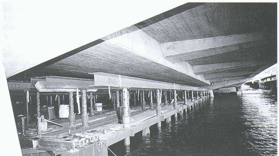
4 Untersicht mit dem teilweise im Wasser liegenden Lehrgerüst
