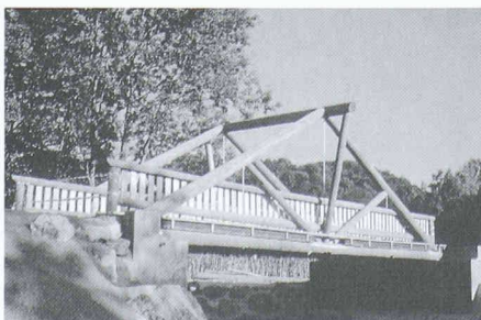
6 Brücken von Surieu: unten die 3,5-t-Brücke, rechts die 30-t-Brücke
