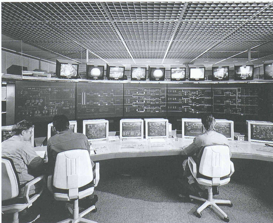
1 Kontrollraum einer hochmodernen Abfallverbrennungsanlage mit Monitoren für alle Betriebsabläufe und Betriebszustände (Bild: ABB-Enetech AG, Winterthur)
