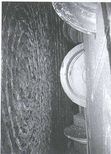
Blick durch Bohrkopf in den Arbeitsraum zwischen Schneidräder und Ortsbrust
