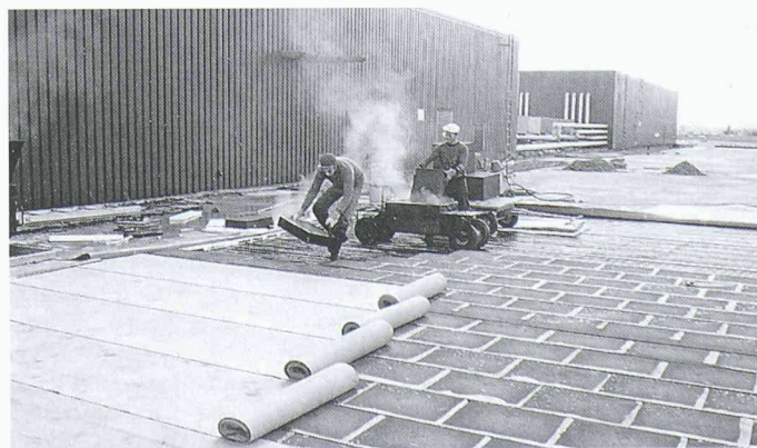
Verlegen der Foamglas-Dämmplatten T4 auf den Trapezblechuntergrund und anschliessende Abdeckung mit Dichtungsbahnen
